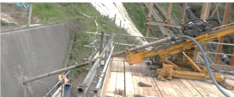
【写真3】施工状況
