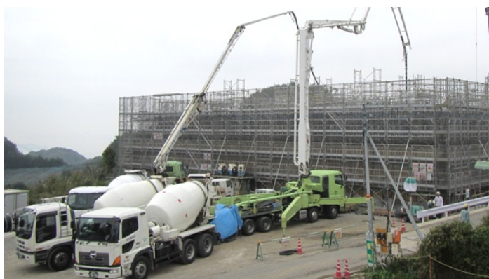
【第2貯留槽の壁コンクリート打設の様子】
